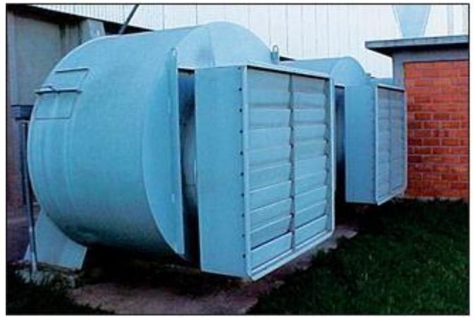
Figura 10: Ventilador ou exaustor
